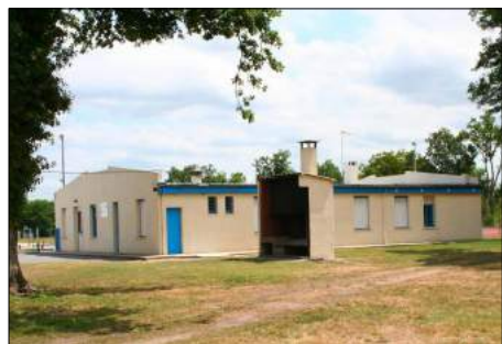
L'ancien foyer construit en 1982 détruit par un incendie en mai 2010
