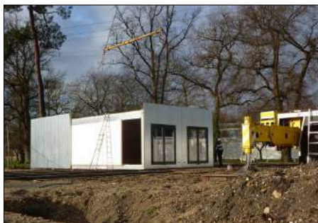
Début de construction du nouveau foyer en février 2013
